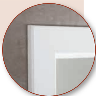
Detail: Zarge SR-Kante mit schmalem Radius an Futterkante und Bekleidung.
